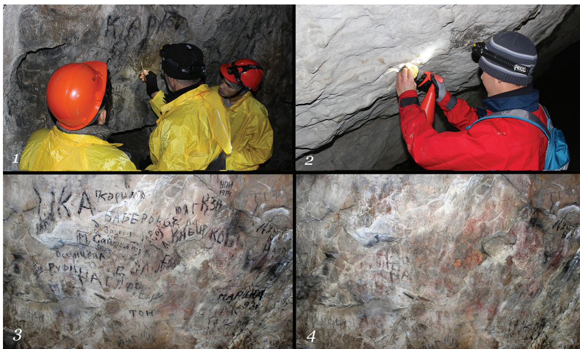
Рис. 2. Реставрационные работы в пещере Шульган-Таш: 1 — процесс расчистки с использованием ватных палочек, низ Ближнего большого колодца; 2 — очистка стен от угольных граффити с использованием pulverизатора и губки, восточная стена Главной галереи; 3 — северная стена зала Знаков до реставрационных работ; 4 — после очистки от граффити
