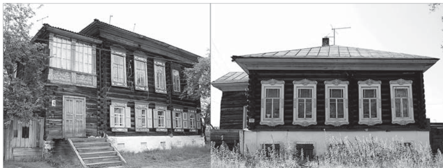
Рис. 2. Памятники II типа. Слева — дом по ул. Бограда, 77 (1870 г.); справа — дом по ул. Фелелова, 105 (1880 г.)
