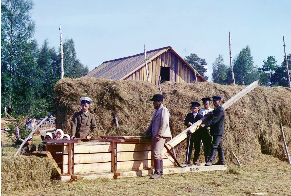
Прессовальный станок для сена. У села Кондопога. 1916 г. Фото С. М. Прокудина-Горского
