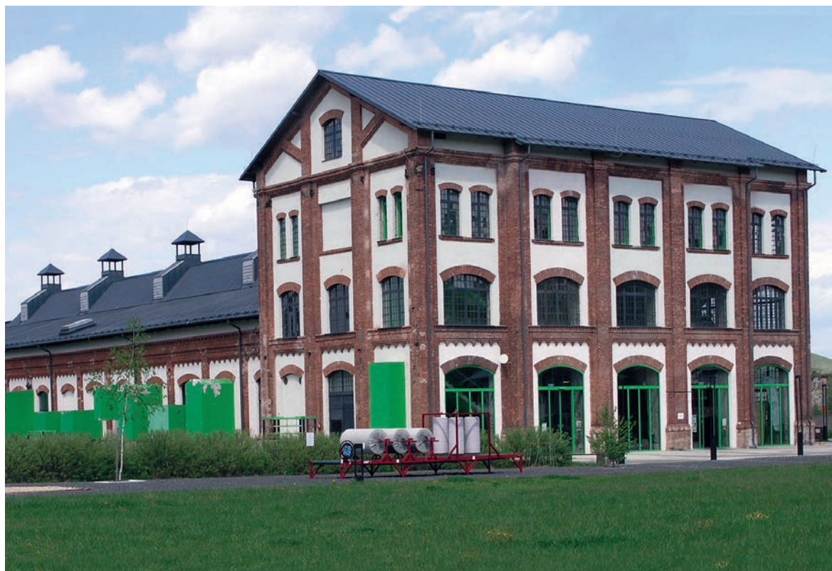
Рис. 1. Национальный тематический парк истории кино (здание воздухоудвки, построено в 1907 г.). Восстановлен в 2016 г. Венгрия, г. Озда. Фото Д. Немет, 2018 г.
